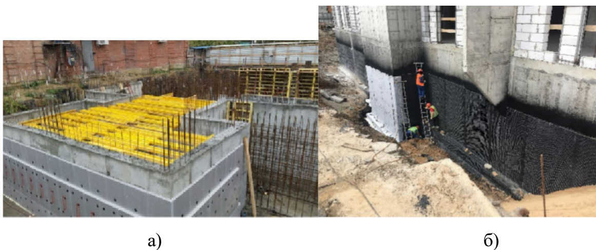
Рис. 1. – Сравнение традиционной гидроизоляции (а) и технологии «белая ванна» (б)
