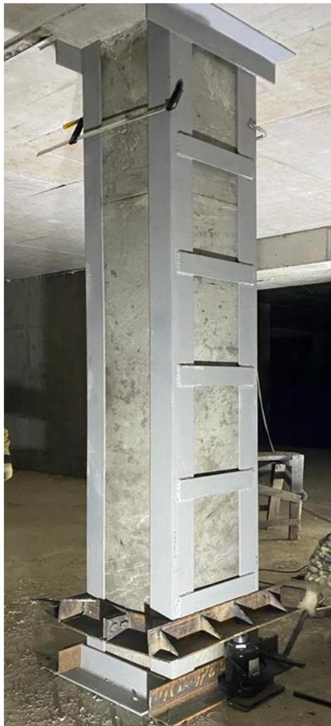
Рис. 3. – Усиление колонны обоймой
