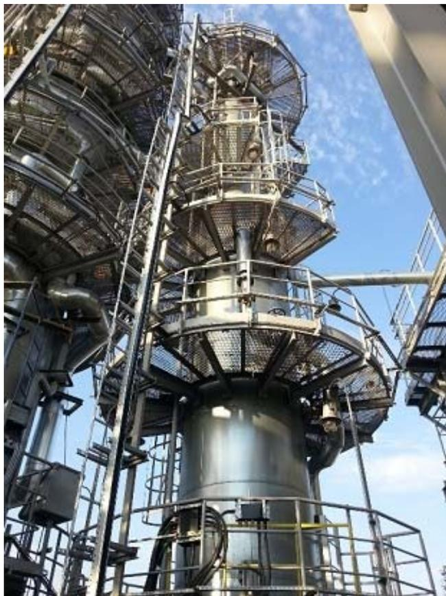
Рис. 1. – Нефтяная колонна с установленными площадками обслуживания
