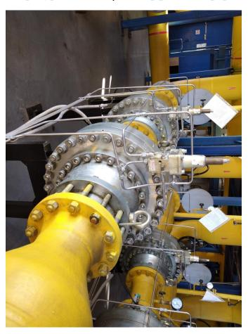
Рисунок 1 – Установка регулятора-монитора и рабочего регулятора в ГГРП № 4
