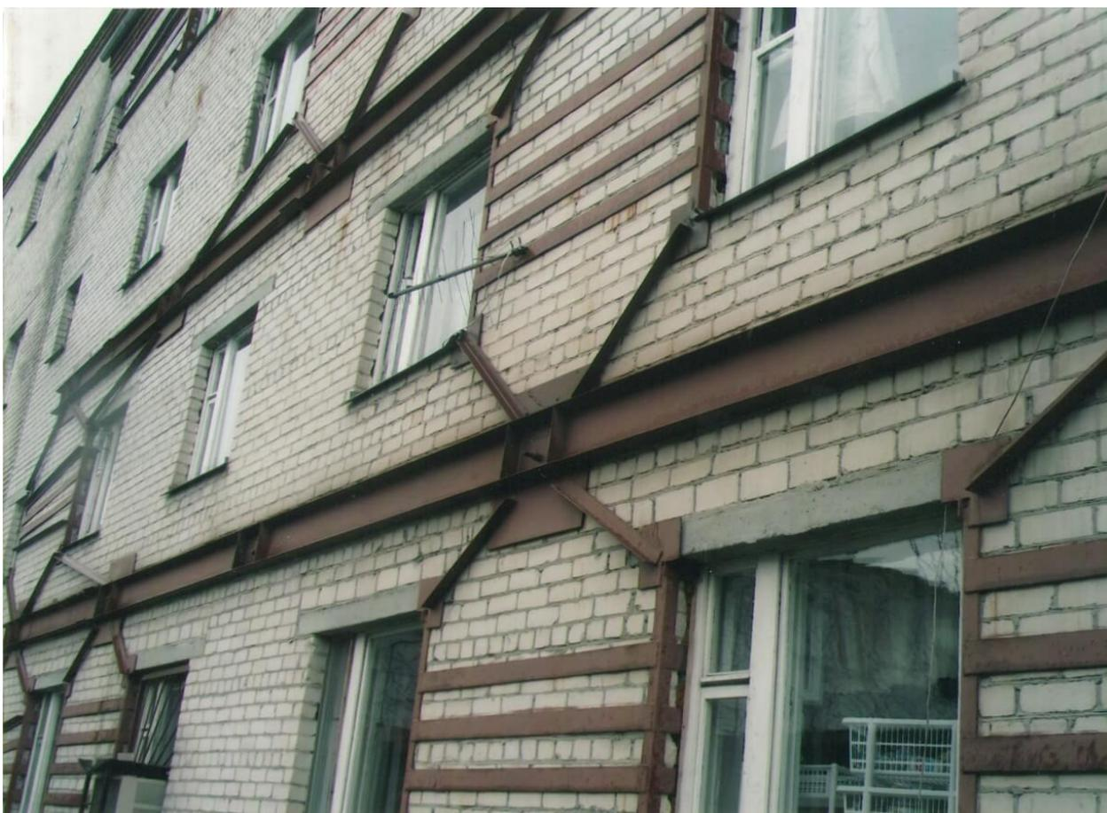
Рис. 5. – Пример усиления конструкций существующего здания стальными поясами [13].
