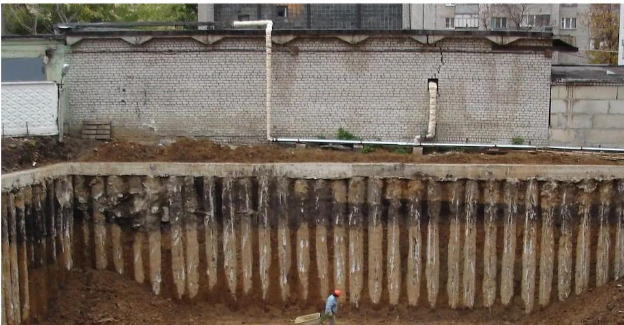
Рис. 2. – Пример устройства котлована в условиях плотной городской застройки [7]
