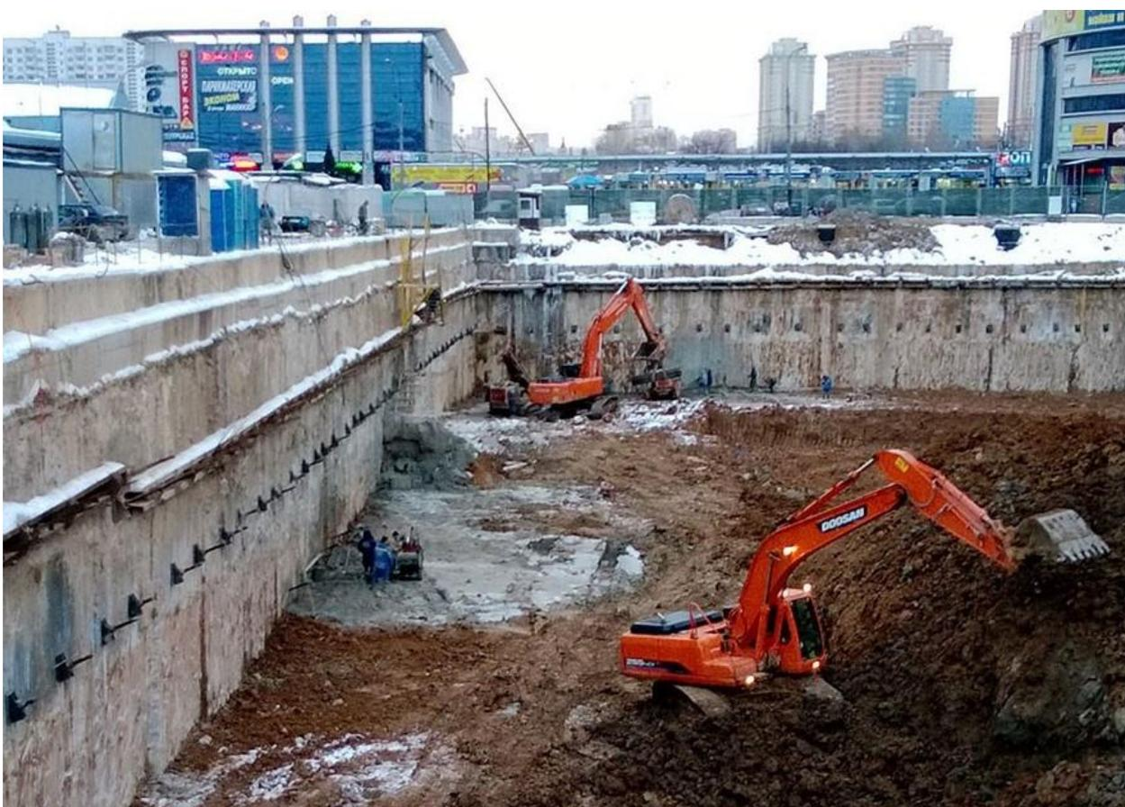
Рис. 3 – Пример крепления вертикального ограждения котлована грунтовыми анкерами [8]
