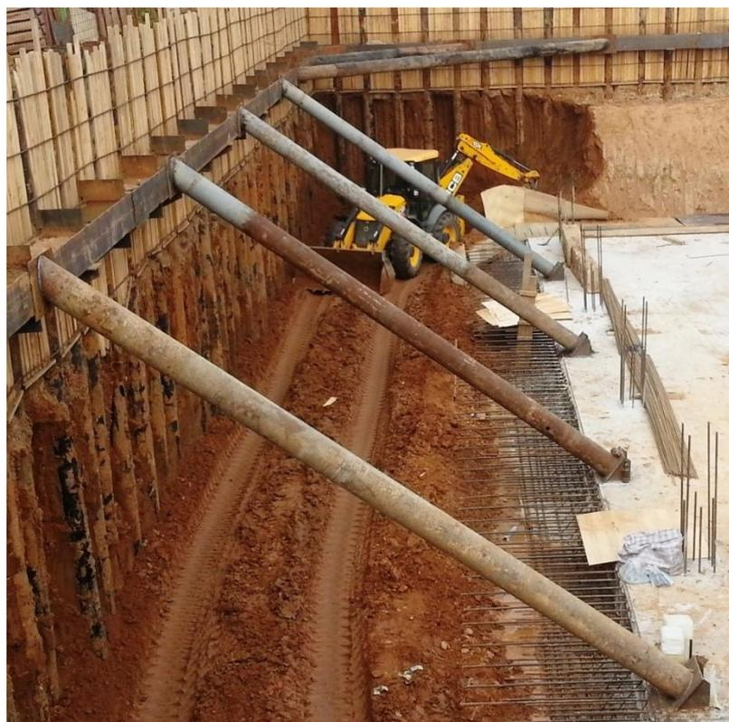
Рис. 4 – Пример крепления вертикальных стен котлована с помощью подкосов [9]
