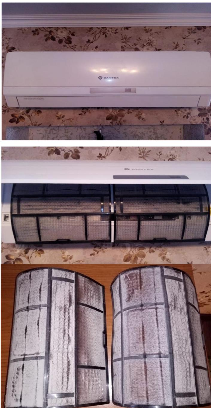
Рис.1,2 – авторские фото сплит-системы DANTEX, фильтры изучаемой сплит-системы
