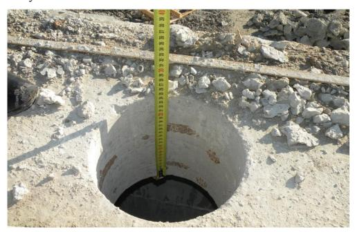
Фото 1. Проем в плите покрытия. Смещение верхней арматурной сетки от проектного положения.
