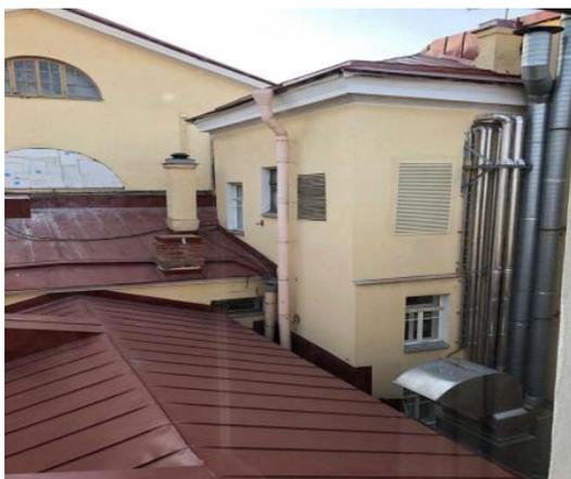
Рис. 2. – Новые инженерные сети (трубопроводы систем вентиляции и кондиционирования) на дворовом фасаде
