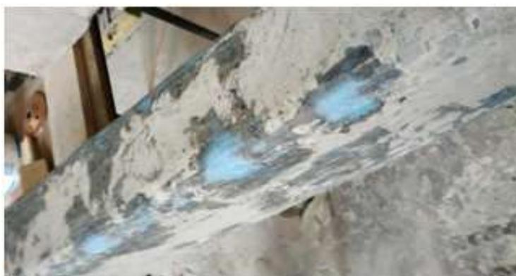
Рис. 7. Общий вид стоек подготовленных под усиление, путем выравнивания поверхности загущённым клеем Монопокс 372.
