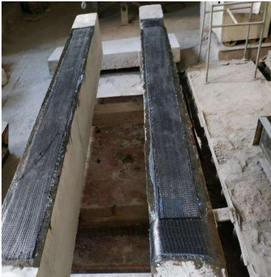
Рис. 12. Общий вид усиленных балок
