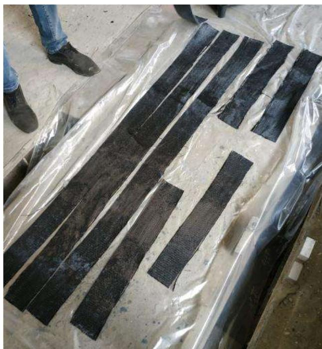
Рис. 10. Углепластиковые холсты Армошел KB-500 разрезанные и подготовленные для пропитки клеящим составом
