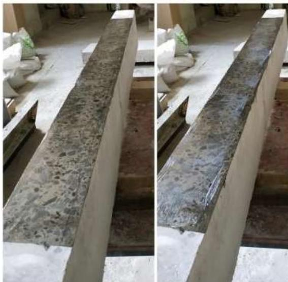
Рис. 8. Общий вид балок в процессе усиления. Слева показано огрунтовывание поверхности, справа – нанесен первый слой загущенного клея Монопокс 372.
