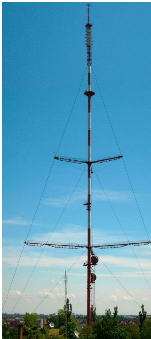
Рис.11 Оттяжки на мачте сотовой связи (фото авторов)
