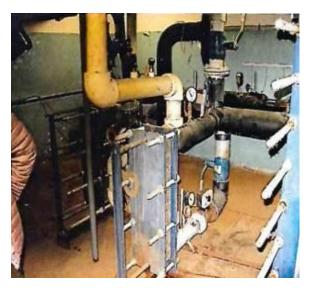
Рис. 1 – Узел системы горячего водоснабжения в центральном тепловом пункте
