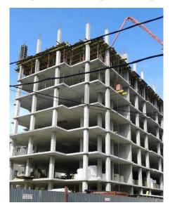
Рис.5. – Строительство монолитно-каркасного дома [3]
