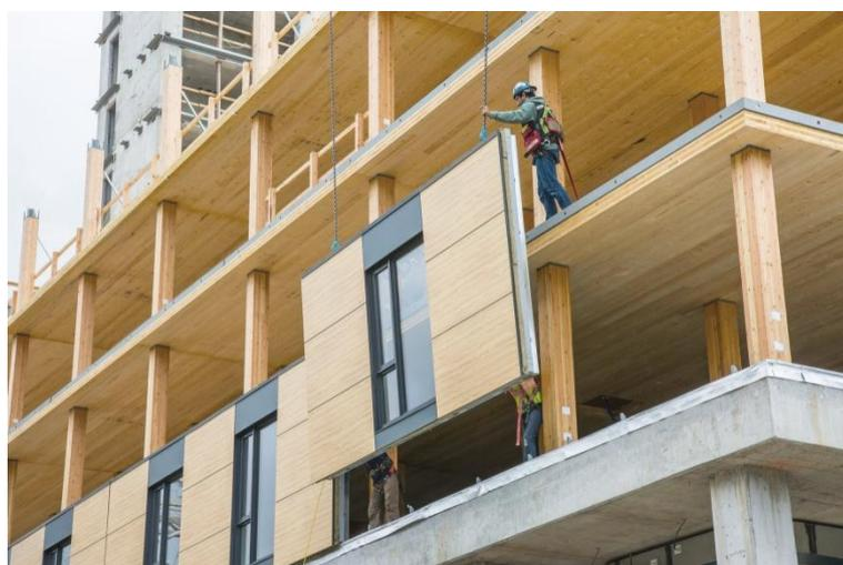
Рис. 2. Реконструкция здания CLT-панелями
