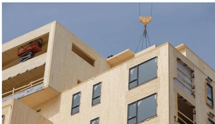
Рис. 1. Возведение здания из CLT-панелей
