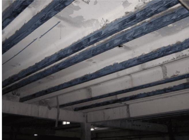
Рис.1. - Усиление ребристых плит покрытия полосами FPR.
