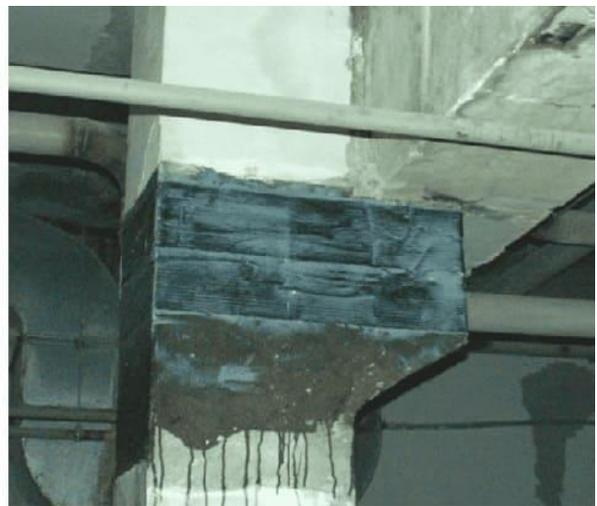
Рис.2.1 Узел усиления консоли колонны.
