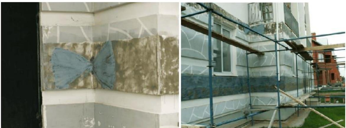
Рис.2.2 Узел усиления стен.
