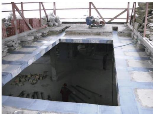
Рис.2.3 Узел усиления проема перекрытия.
