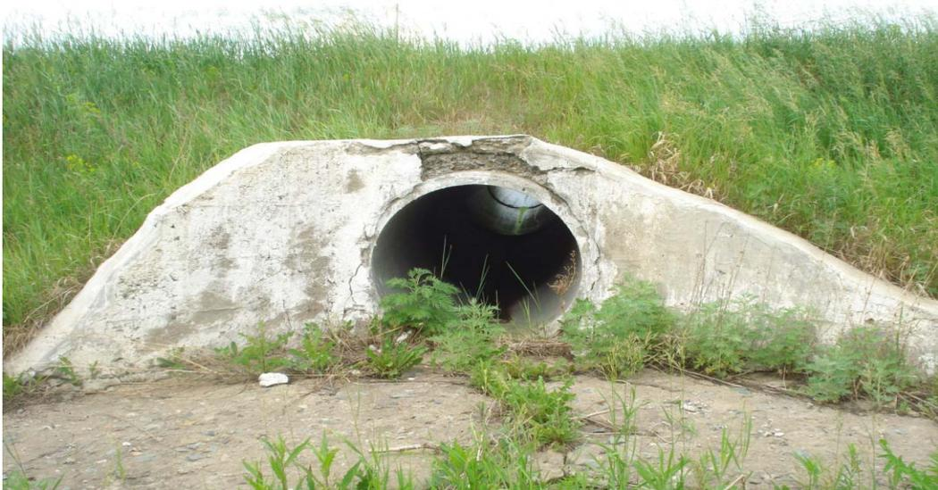
Рис.4.- Техническое состояние существующих водопропускных труб
