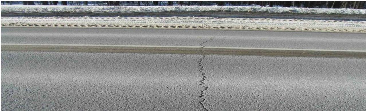
Рис.1. - Поперечные трещины
